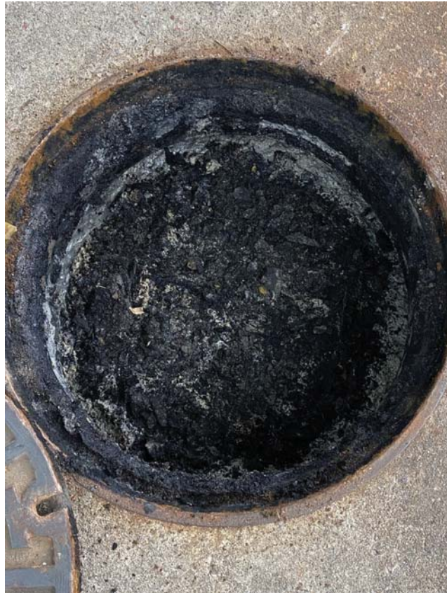
- ปริมาณไขมันในบ่อดักไขมันท่อที่ 1 ก่อนทำการสูบล้าง
