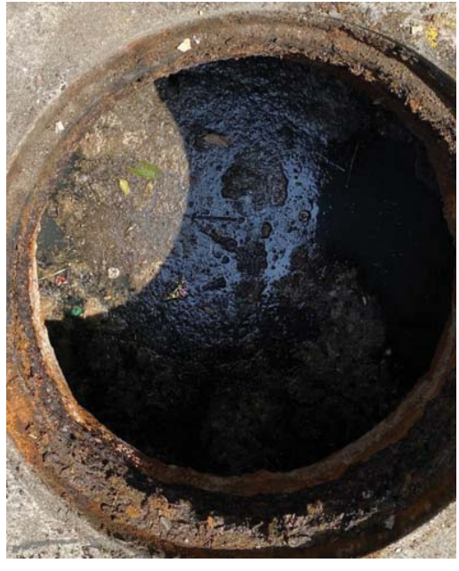
- ปริมาณไขมันในบ่อพัก ไขมันฝาท่อ 4 ก่อนทำการสูบล้าง
