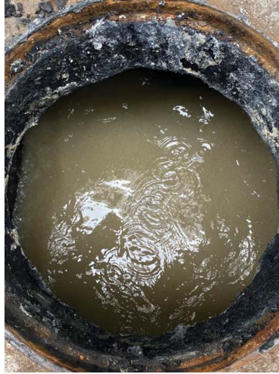
- หลังจากสูบล้างไขมันลงท่อในบ่อดักไขมันแล้ว
