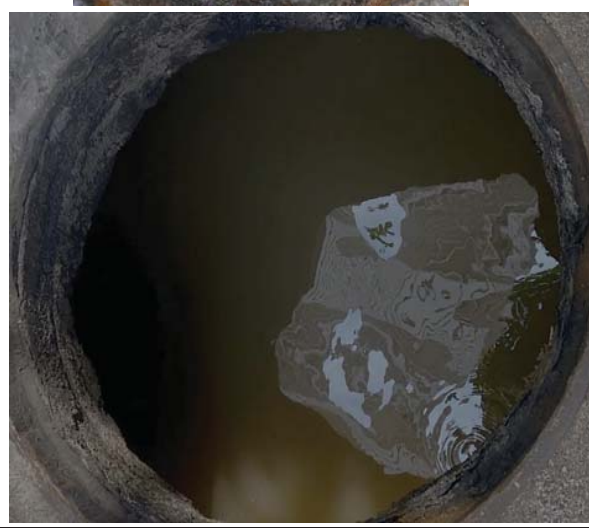
- ท่อระบายน้ำในซอย 3 ไม่พบว่ามีท่อระบายน้ำ เพราะตะกอนทั้งหมดจะอยู่ด้านล่าง ซึ่งบ่อนี้แนะนำให้ทำการสูบล้างท่อระบายน้ำและล้างถังสูบล้าง เพื่อไม่ให้ระบบบำบัดน้ำเสียกลับมาทำงานได้อย่างมีประสิทธิภาพเหมือนเดิม
